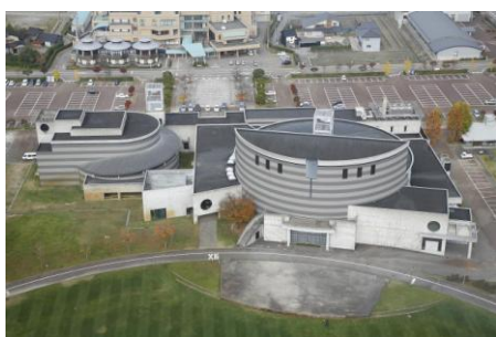
左側の建物がセレナホール
